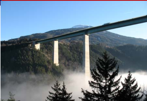
«Europabrücke» Innsbruck, Austrija, 1963.
